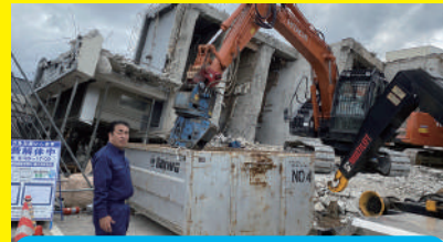
ようやく撤去が進む解体現場(輪島市にて)
